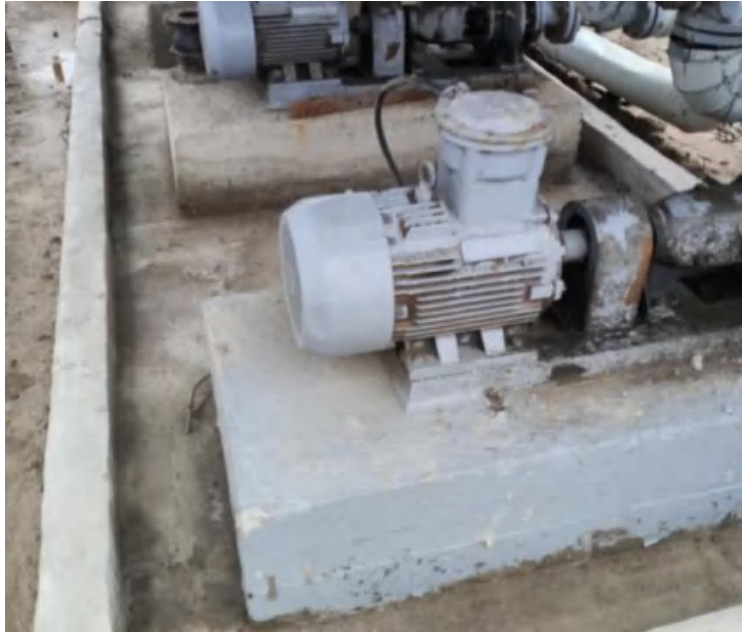
图 4.2-5 降噪措施实际建设情况
