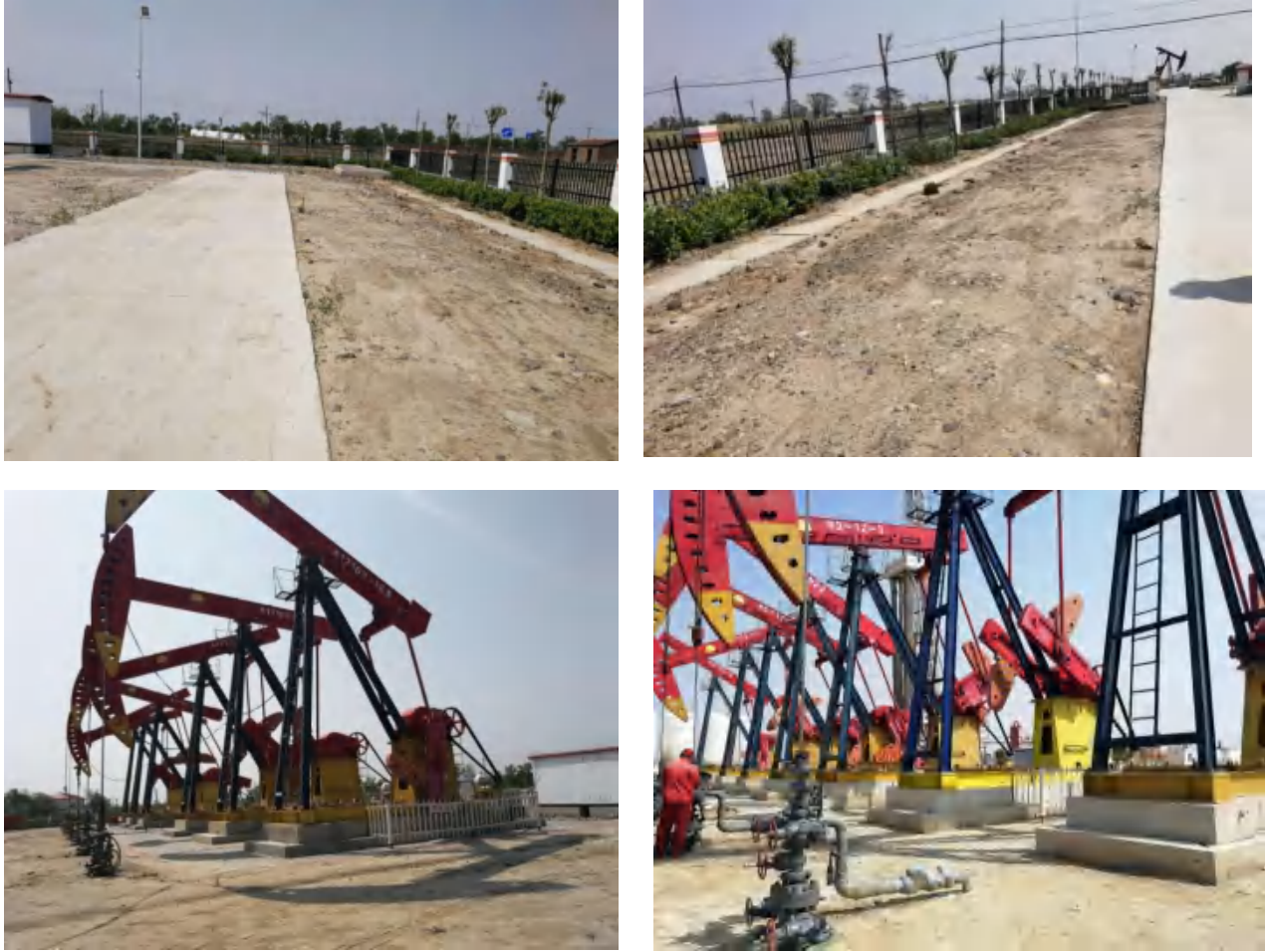
图 6-1 井场平整恢复情况
