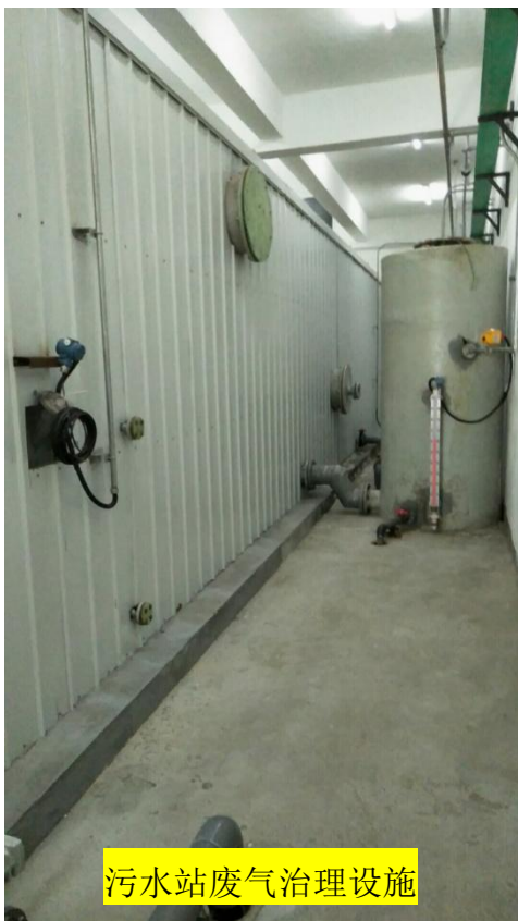
污水站密闭池体及废气收集管道
