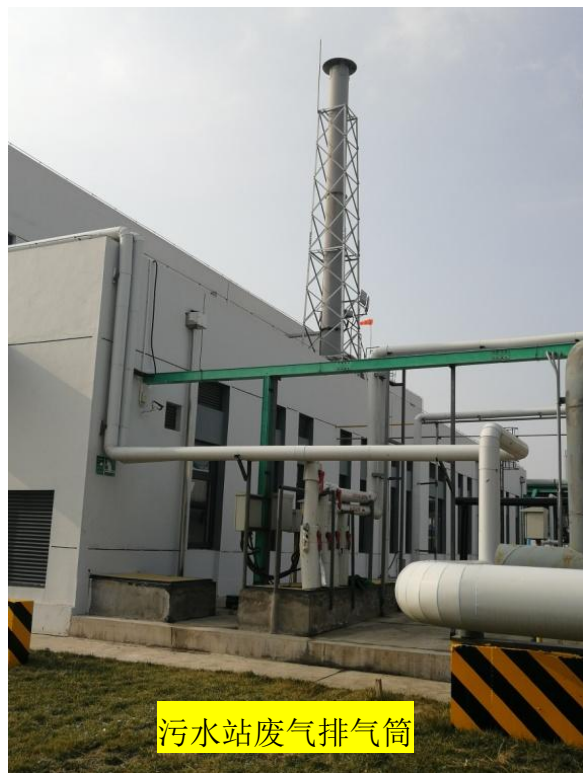
图 4-2 污水处理站废气处理设施
