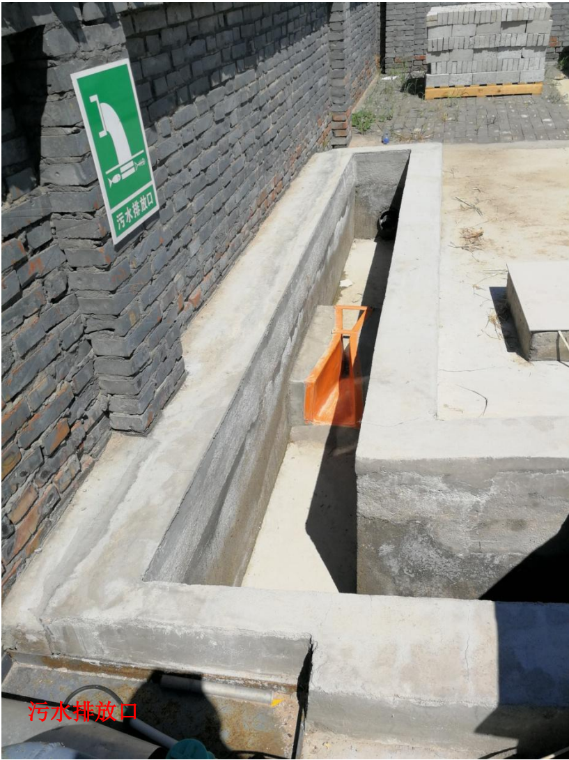
图 4.2-3 厂区污水处理站实际建设情况
