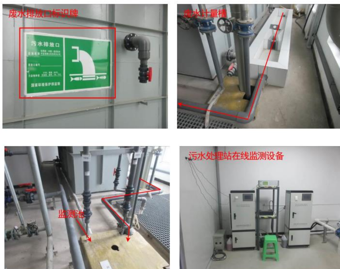
图 4.2-4 厂区污水处理站实际建设情况
