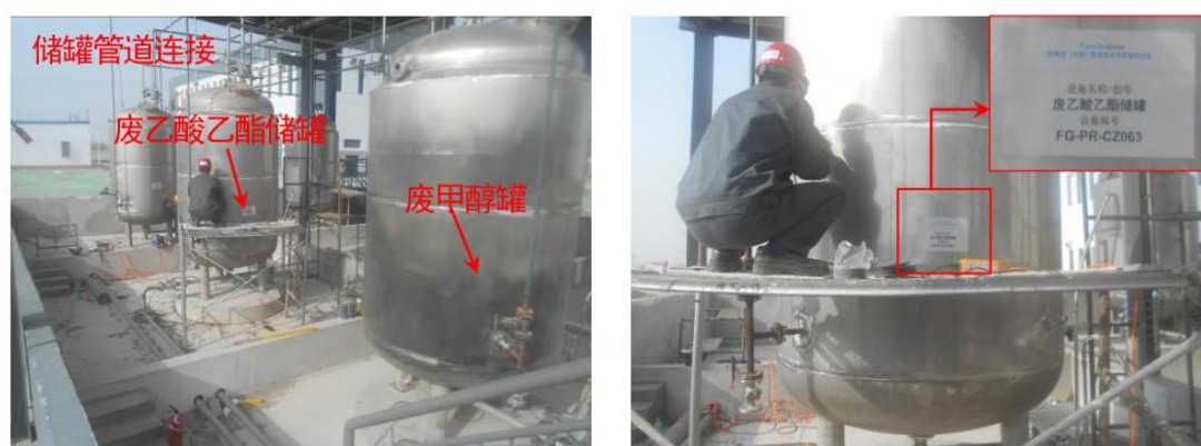
图 4.2-7 危废储罐建设情况
