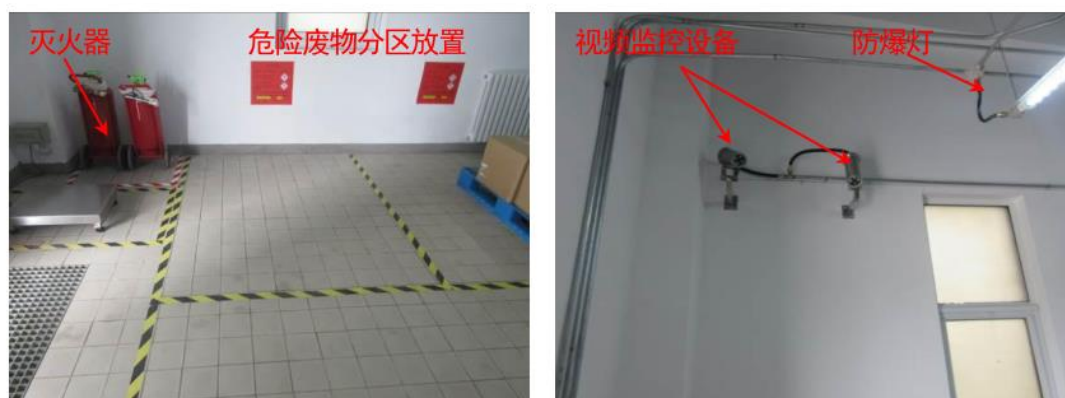
图 4.2-6 化学品库(含危废库)建设情况
