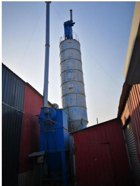
图 4-1 水泥筒仓、布袋除尘器照片
