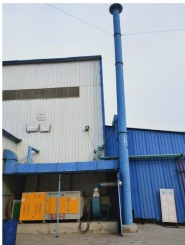
图 3-7 西侧光氧催化装置现场照片
