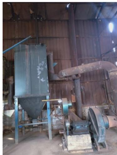
图 3-8 燃油锅炉布袋除尘器及排气筒现场照片
