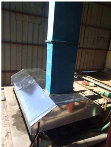
图 3-5 真空泵循环水池集气罩现场照片
