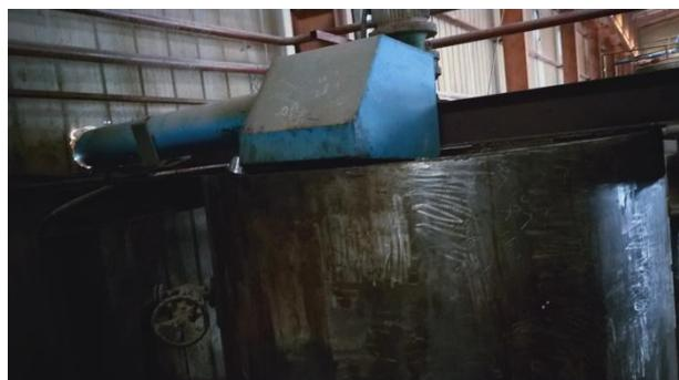
图 3-2 成品油中间罐集气罩现场照片
