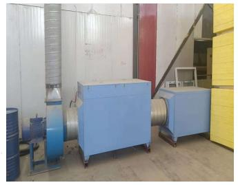
图 4.2-3 本工程废气治理设施(除尘器、除尘器、除尘器、UV 光氧+活性炭) 4.2.3 噪声
